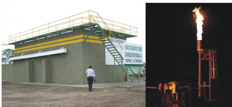
Figura 4. Biorreactor trabajando con vinaza en una destilería de alcohol tucumana
