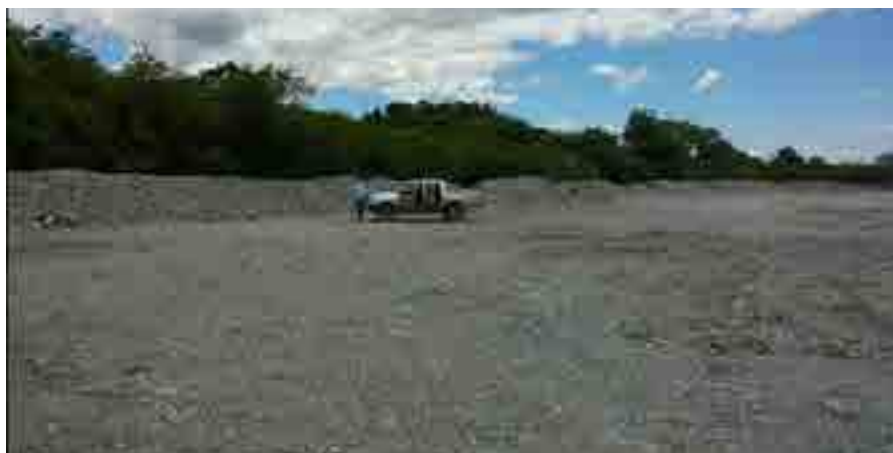
Fig.4- Se observa depositación de material de descarte que hace de contención a futuras y probables desbordes en el río Tipas debido a la agradación que sufre dicho Río.
