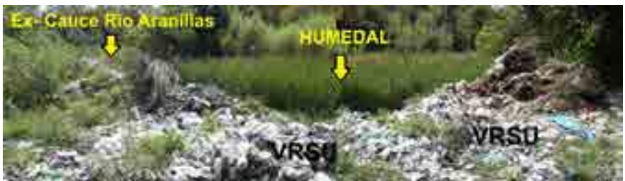
Fig. 2: Vista al ONO mostrando el viejo cauce con desarrollo del humedal y los RSU dispuestos sobre borde e interior de la estructura del meandro.
